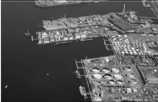
【名古屋港(エネルギー輸入基地)】
