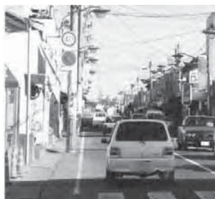
＜歩行の支障となる電柱＞
