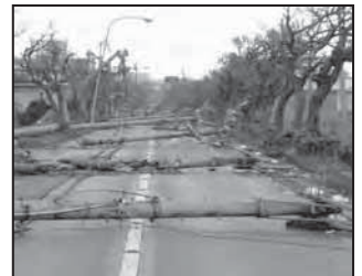
(台風による道路の被災状況)
