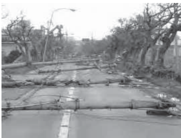
＜電柱の倒壊による道路閉塞＞
