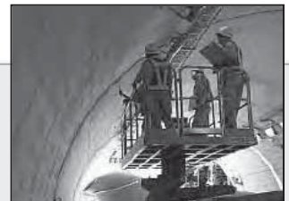
(道路構造物の点検)
