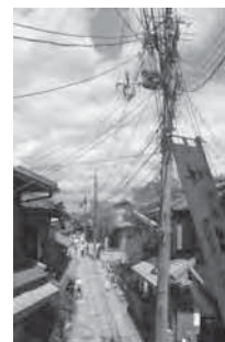
＜美観を損ねる電柱・電線＞
