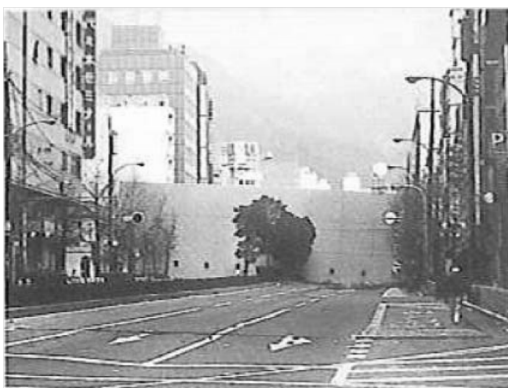
阪神・淡路大震災において建物の倒壊により道路が閉塞された状況
