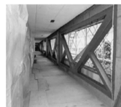
鉄骨ブレースによる壁の補強
