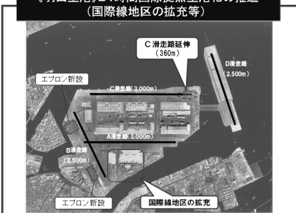
《羽田空港》24時間国際拠点空港化の推進 (国際線地区の拡充等)
