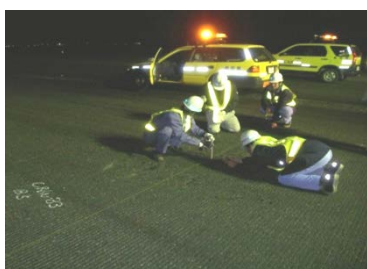
(基本施設点検実施状況)
