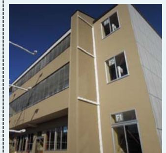
その他の部分との接合がなく、構造的に独立した防火壁 ※防火戸についても壁との接合部等を工夫
