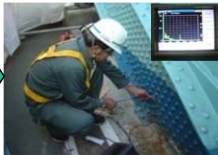
超音波による非破壊検査
