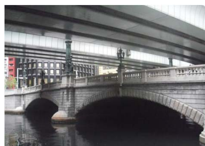
▲上空を首都高速に覆われた日本橋
