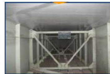
炭素繊維補修
