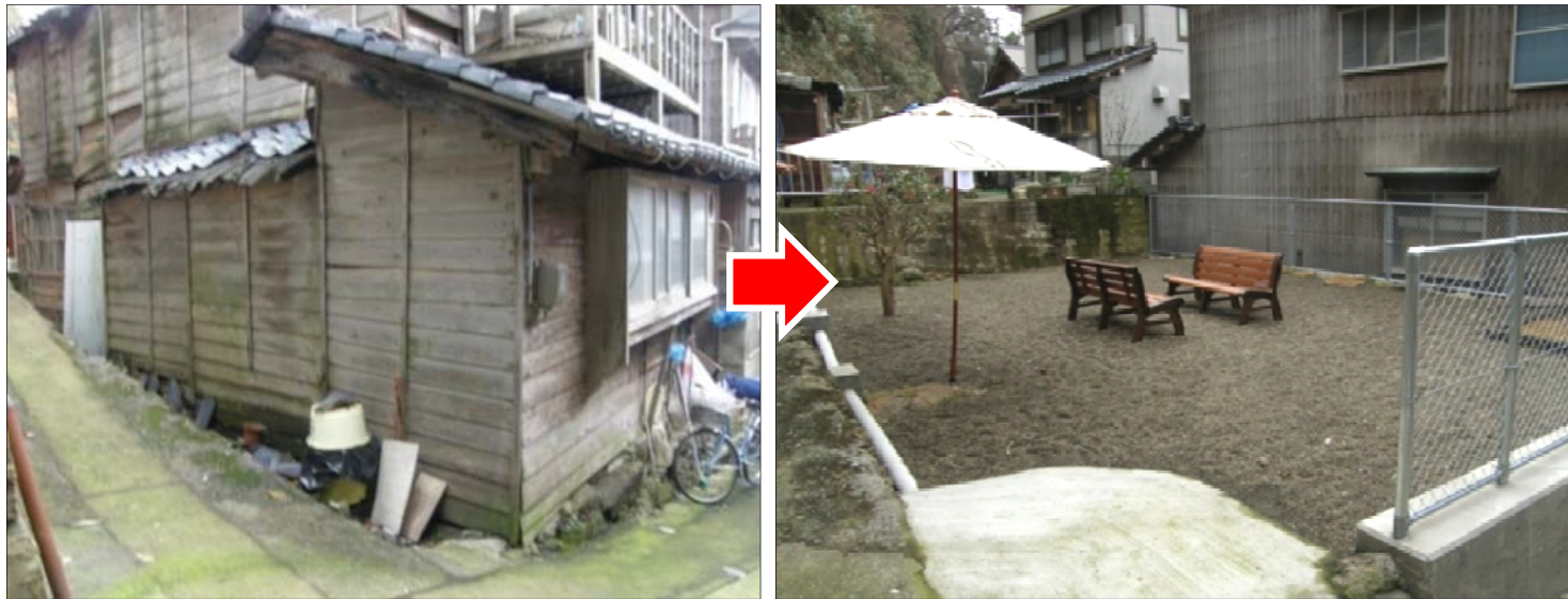
【福井県越前町】 老朽化した空家住宅を除却し、ポケットパークとして活用
