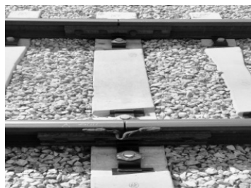
線路設備 (軌道改良(PCまくら木化))
