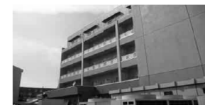
外壁を取りはらって窓とベランダを整備
