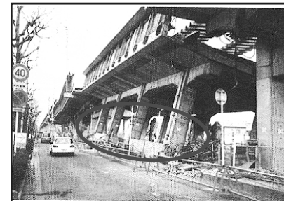
高架橋等が大きく破壊し倒壊する被害が発生
