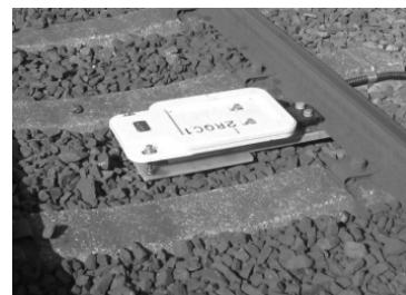
信号保安設備 (自動列車停止装置(ATS)の更新)
