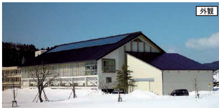
【雪冷熱利用の公共施設[小学校](新潟県上越市)】
