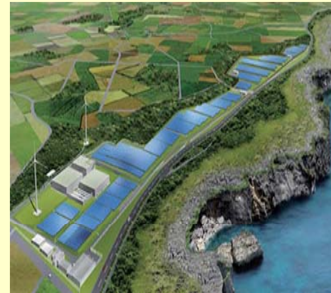
宮古島のスマートグリッド実証試験設備
