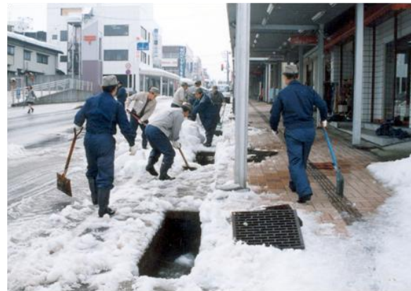
【流雪溝を活用した地域住民による除雪活動の状況】
