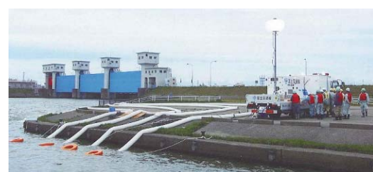
排水ポンプ車の稼働光景(イメージ)
