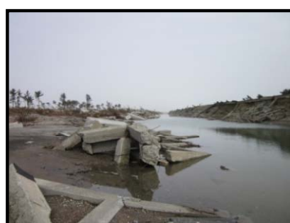
堤防の陸側に大きな洗掘溝。松林の一部は残存
