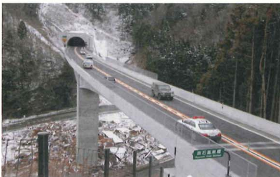
緊急輸送路として機能した三陸縦貫自動車道
