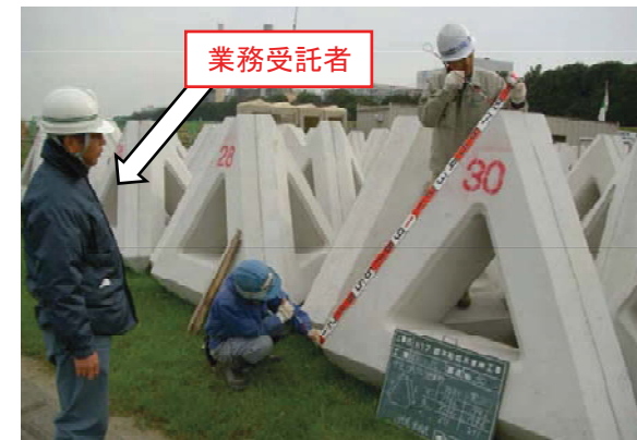
(工事監督支援業務:根固めブロックの材料確認)
