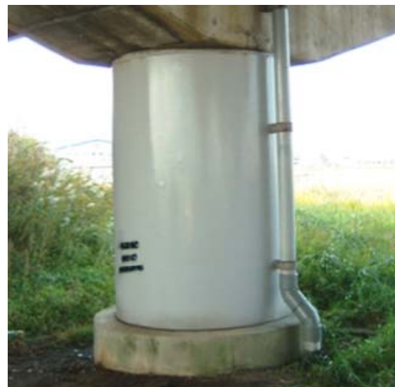
鋼板巻立て補強
