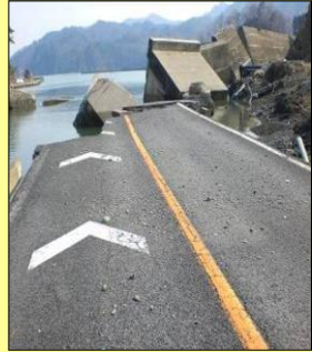
津波で被災した国道45号
