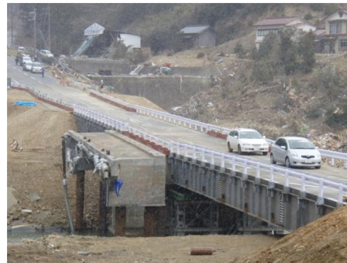
▲応急復旧後(4月4日15時開放)
