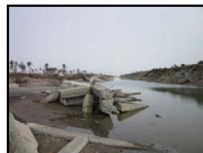
堤防の陸側に大きな洗掘溝。松林の一部は残存
