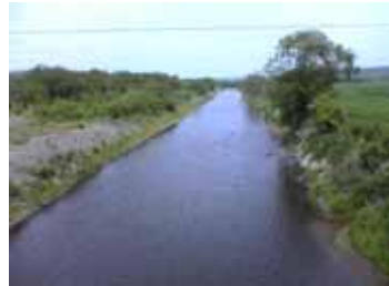
写真 光橋付近の河道状況
