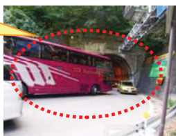
▲入山トンネル坑口付近
