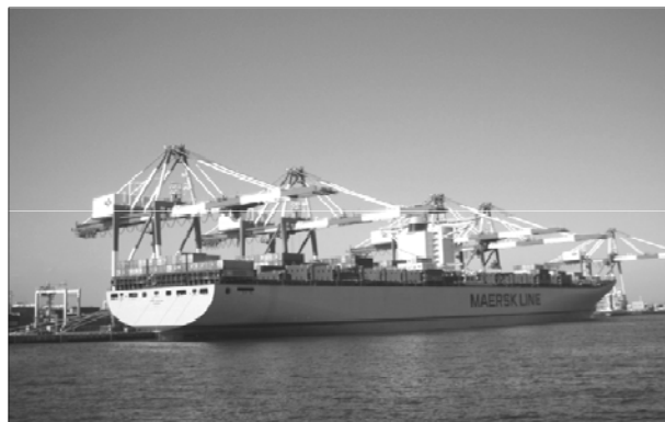
【横浜港 南本牧コンテナターミナル(MC-2)】
