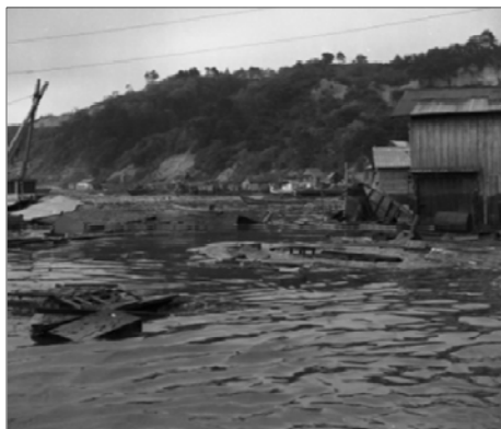
【津波による家屋の浸水状況】
