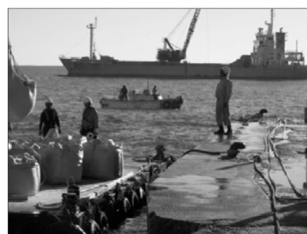
【南鳥島の現状】 港湾施設が整備されていないことにより 台船に積み替えて物資等を陸揚げ
