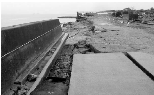
【被災した海岸堤防(平成16年度)】
