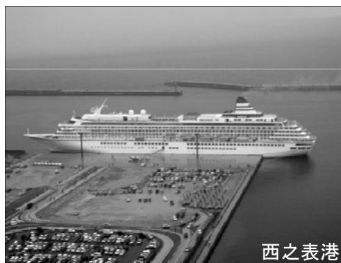
西之表港 【岸壁延長の不足による不安定な係留】
