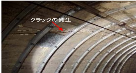
トンネル(改修前)
