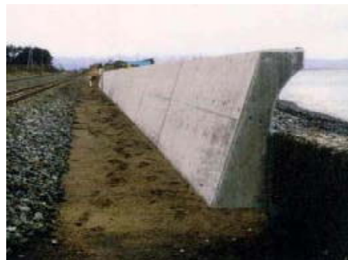
【護岸壁の一例】
