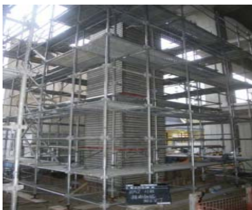
鋼板巻きによる耐震化
