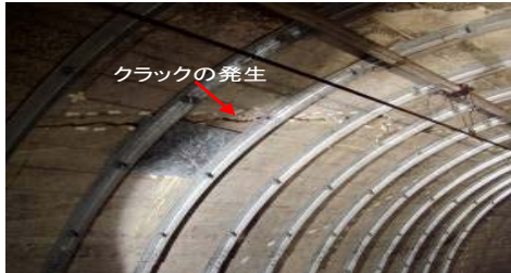
トンネル(改修前)
