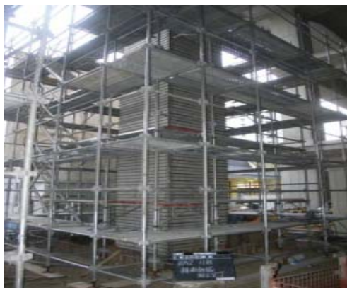
鋼板巻きによる耐震化
