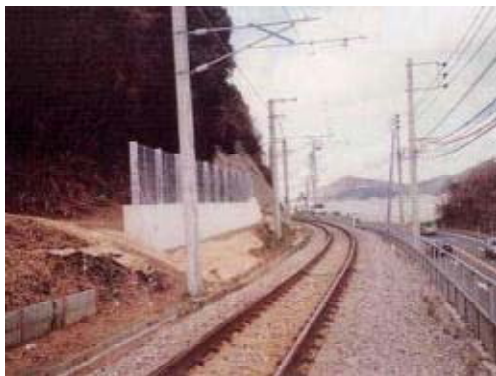
【落石防止擁壁の一例】
