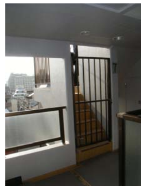
屋上階段施設状況
