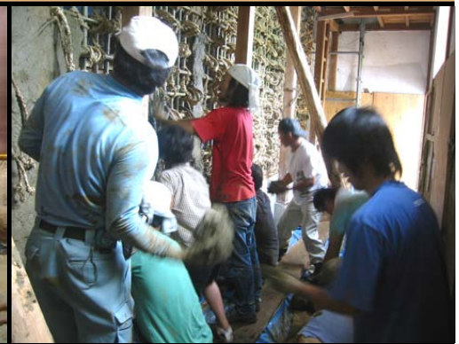
泥団子を作って現場へ運び込み 竹小舞目掛けてカー杯「手打ち」
