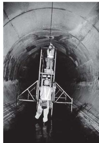
〈管きょ内での作業〉
