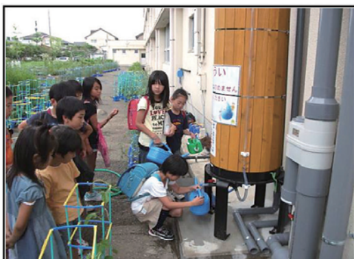
小学校での雨水貯留施設の活用
