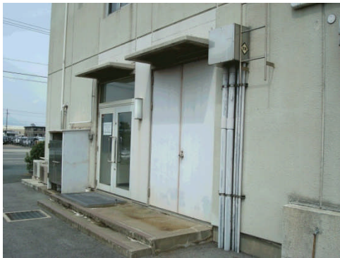
1階電気室の搬入口 外部から20cm程しか上がっていないため高潮による浸水の可能性が高い。
