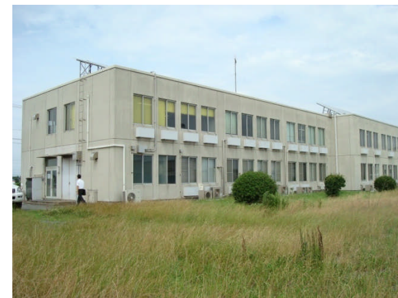
既存庁舎(豊橋港湾合同庁舎)
