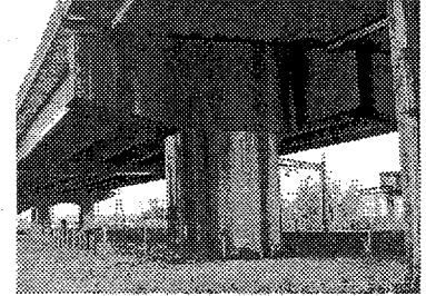
【耐震補強の実施により新潟県中越地震では甚大な被災無し】
