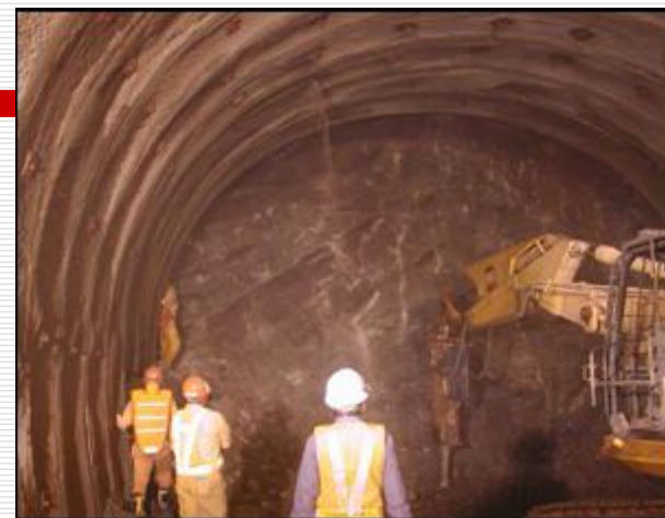
トンネル内でのCMR(手前)の活動状況
