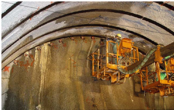
対策工(長尺先受工)の施工例
