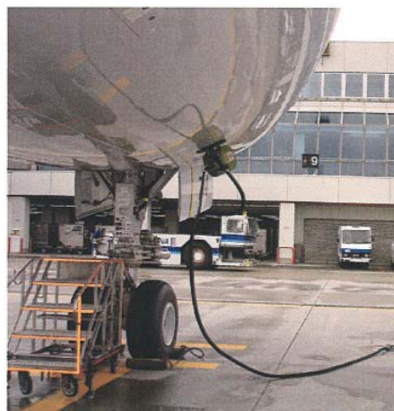
■ GPU（地上動力装置）
