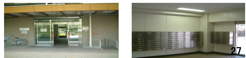
エントランス改修
