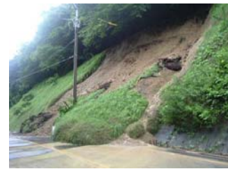
被災状況写真
