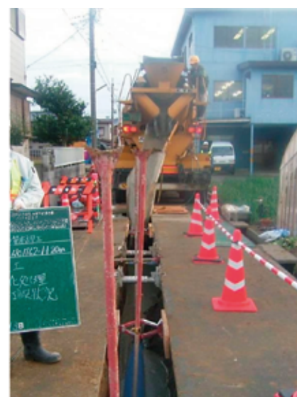
写真：流動化処理土打設状況
