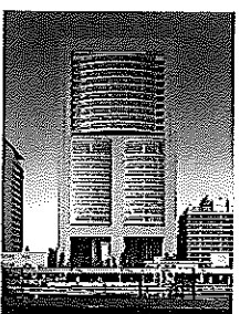
JR東日本本社ビル 東京都 1997年
