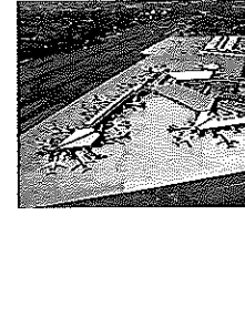
成田国際空港旅客ターミナルビル 成田市 1973年~
