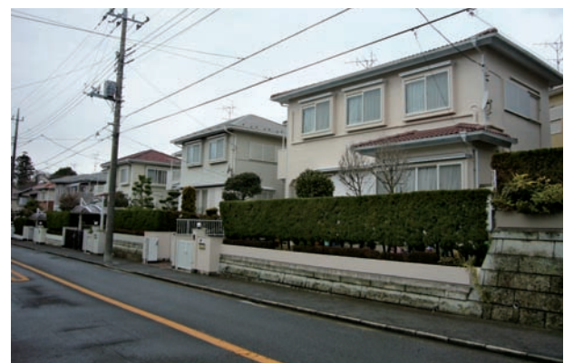
大谷石の擁壁と生垣が連続する街並み
