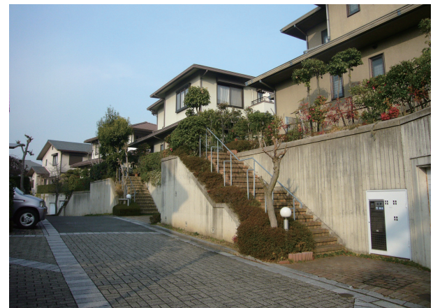
北側アプローチの住宅
