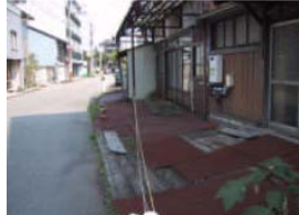
【暗渠区間の開渠化】
