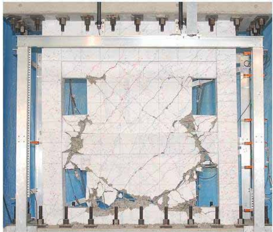
1層壁板がせん断破壊
