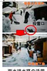
雨水排水路の活用
