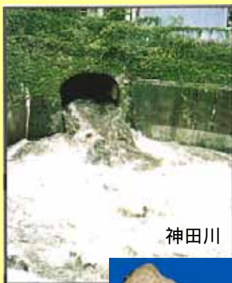
未処理汚水の放流状況
