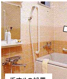
手すりの設置
