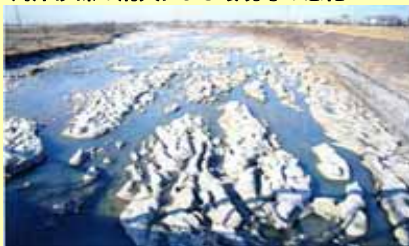
河床砂礫の消失による環境等の悪化
