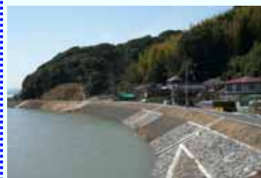
堤防の整備(高知県国分川)
