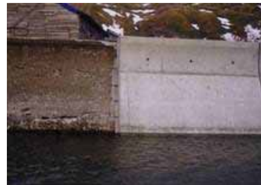
老朽化対策による改良例
