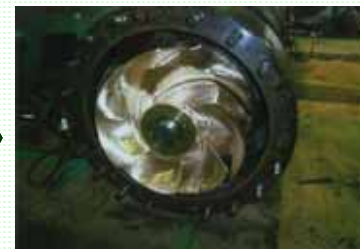
ポンプの構成部分の一部(羽根車)を取替え、利用可能な部分を引き続き使用
