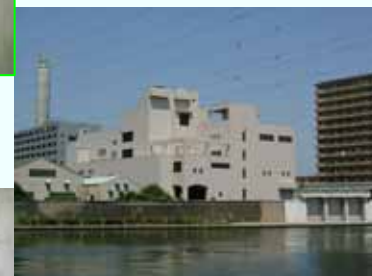
ポンプ場の整備 (東京都 神谷ポンプ場)
