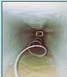
プラスチック材により既存の下水道管の内面を被覆
