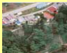
急傾斜地における緑を活かした斜面对策
