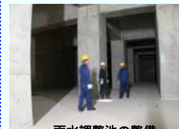
雨水調整池の整備 (名古屋市 平田第二雨水調整池)
