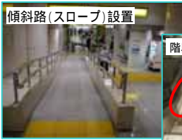
傾斜路(スロープ)設置
