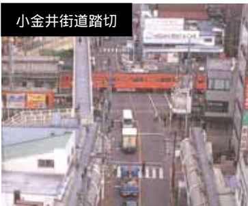
対策前の状況
