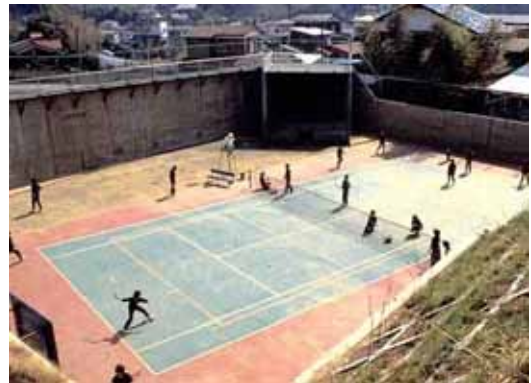
雨水貯留浸透施設
