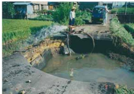
道路陥没に伴う土砂流出状況
