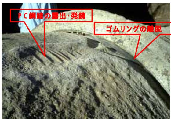
継ぎ手部からの漏水により
