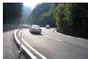
2車線 + 歩道整備
