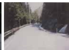
1車線 + 待避所設置
