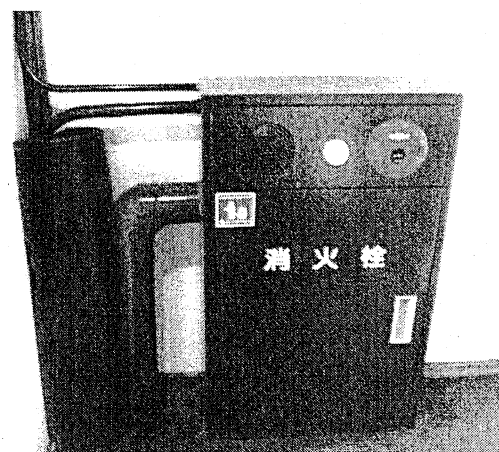
【消火栓の整備】
