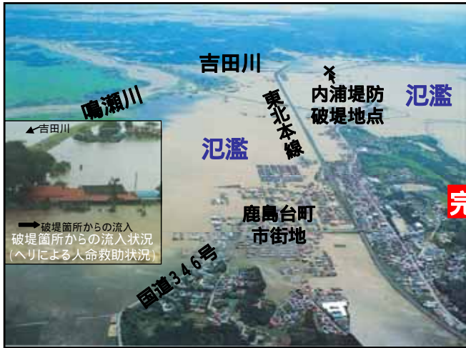
S61.8洪水による浸水状況
