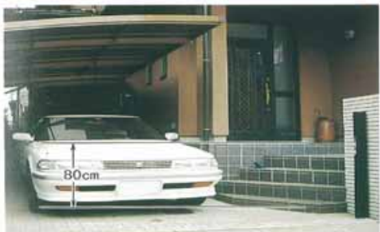
改築時に80cm床上げ(真間川流域)
