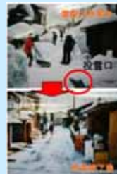
雨水排水路の活用
