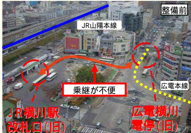
駅前広場内へ広電の電停を移設、改良等を行うとともに、J Rの改札口を移設し、交通結節点機能の強化と、相互間の乗継負担の軽減を図った。
