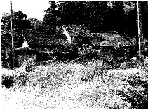
写真5.10.1 住宅の棟瓦の落下
