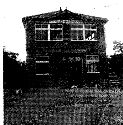
写真 5. 16. 2 旧校舎（南校舎）妻面
