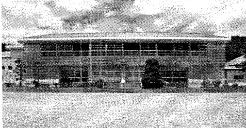
写真5.3.1 体育館南側全景
