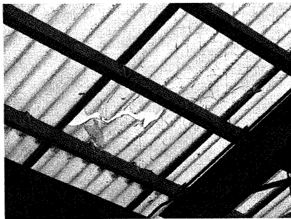
図9 被害のあった網入波型ガラス箇所（同左）
