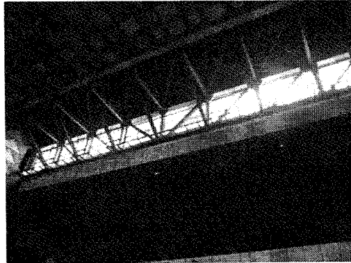
写真5. 4. 2 高窓部分内部鉄骨トラス
